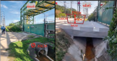
ปรับปรุง ขยายระยะระบายน้ำ G6 ท้ายโรงงาน จากท่อกลม เป็นราง V-Ditch
